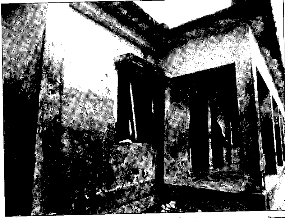
মোরেলগঞ্জ (বাগেরহাট): উপজেলার পশ্চিম জিউধরা সরকারি প্রাথমিক বিদ্যালয়ের ঝুঁকিপূর্ণ ভবন
