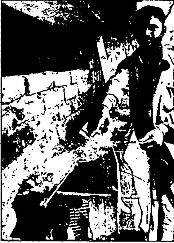
কমলনগরে ভবন তৈরিতে রডের পরিবর্তে ব্যবহৃত হচ্ছে কঙ্কি - যাযাদি
