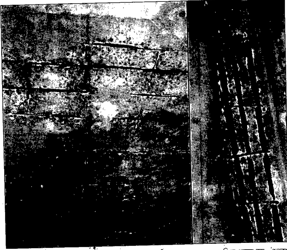
চাঁপাইনবাবগঞ্জ: বাসুদেবপুর উচ্চ বিদ্যালয় ভবনের ছাদ ও বিমের পলেস্তরা খসে বেরিয়ে পড়ছে রড -জনকণ্ঠ
